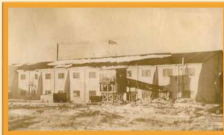
Строительство нового лесоцеха (1938)
